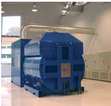
Fuente ARGEM. Célula de combustible, 250 kW para producción de electricidad, calor y frío. © NAVANTIA
