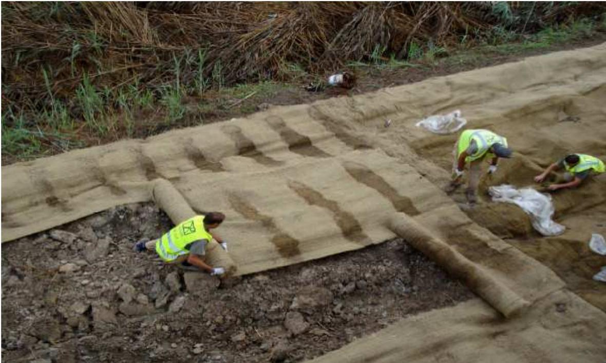
Figura 10. Instalación de manta de esparto.
