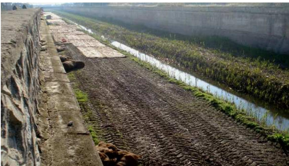
*Figura 9. Instalación de colchón de coco.*
