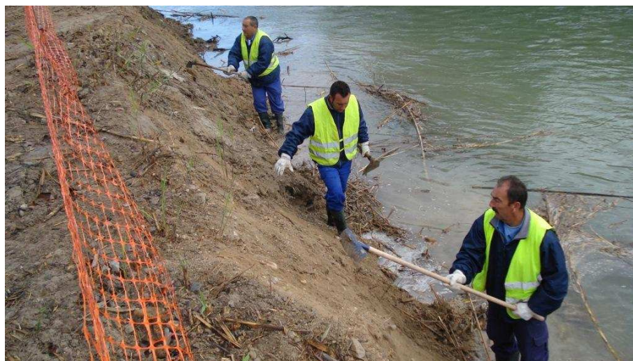
Figura 8. Retirada manual del rizoma. Fuente: TRAGSA.
