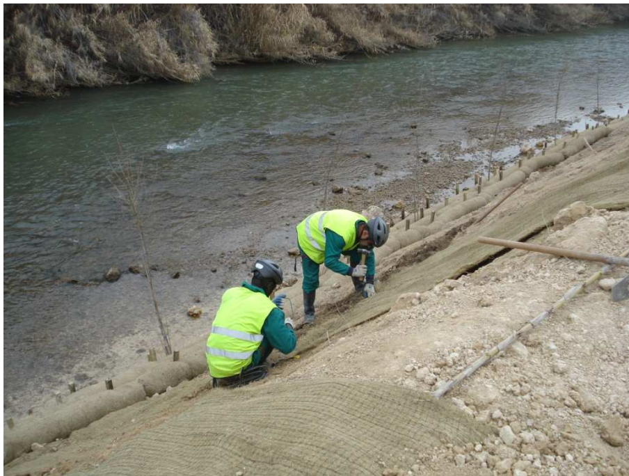
Figura 11. Colocación de manta orgánica de esparto. Fuente: TRAGSA.
