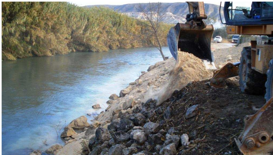
Figura 9. Reconstrucción del talud. Fuente: TRAGSA.
