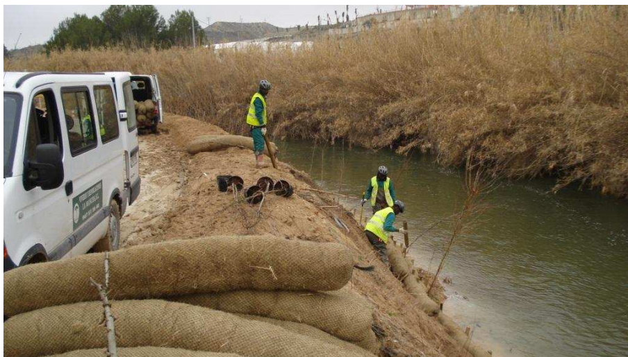
Figura 10. Colocación de biorrollo y plantación de sauces ( Salix sp. ). Fuente: TRAGSA.
