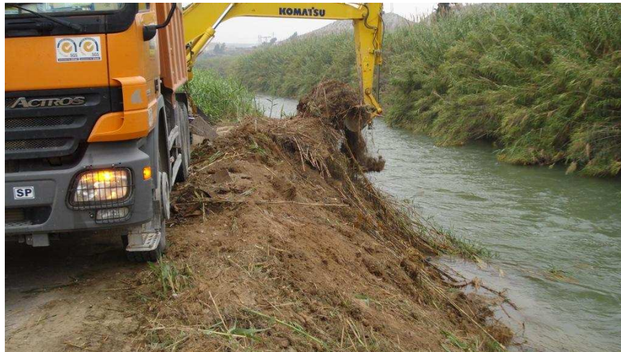
Figura 7. Retirada mecanizada del rizoma. Fuente: TRAGSA.
