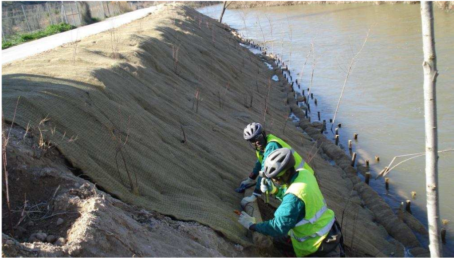
Figura 12. Colocación de manta de esparto y plantación de Tamarix canariensis . Fuente: TRAGSA.
