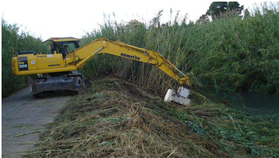
Figura 5. Desbroce mecanizado. Fuente: TRAGSA.
