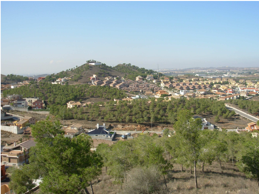
Figura 25: Mancha interior pequeña.
