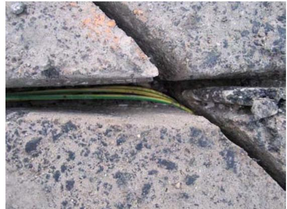
Las características del lazo inductivo (tamaño, número de vueltas que da el cable...) permiten prepararlo para que tenga una determinada frecuencia de resonancia  $\omega = 1/\sqrt{LC}$ , donde  $L$  y  $C$  son, respectivamente, la inductancia y la capacidad del lazo. Esta frecuencia de resonancia (entre 10 y 200 kHz) se monitoriza constantemente desde la caja de control.
