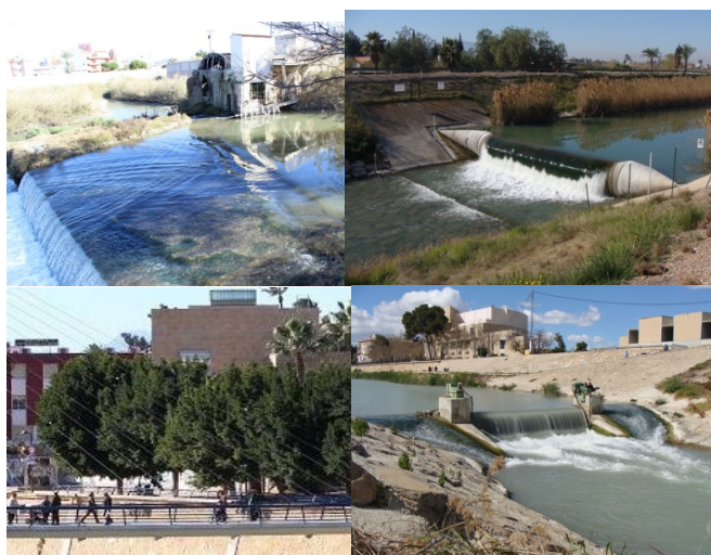
Figura 10. Tipologías de obstáculos inventariados en el tramo objeto de estudio (Azud Contraparada, Murcia-Desembocadura río Segura, Alicante). Azud de Formentera, azud de mampostería con salto vertical (arriba izquierda); Azud de Beniscornia, presa hinchable desbordable (arriba derecha); Azud de Manterola, azud de mampostería con salto inclinado (abajo izquierda); Azud de la Fica, azud de compuerta mecánica con rampas laterales (abajo derecha).
