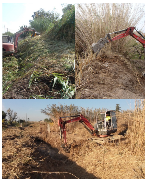
Figura 8. Actuciones de eliminación de caña ( Arundo donax ) en los tramos objeto de rehabilitación. Consiste en la corta de la parte aérea y la retirada del rizoma mediante procedimientos mecánicos.
