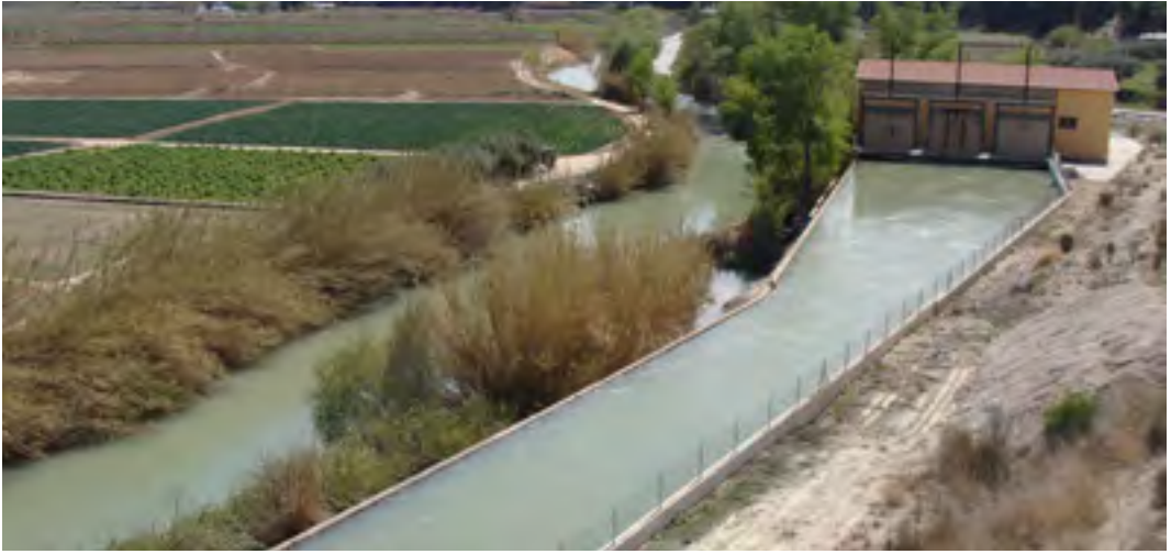
▲ Los usos agrícolas y las infraestructuras hidráulicas han modificado profundamente la vegetación de ribera de los tramos medios y bajos de la cuenca. En la imagen se observa la práctica ausencia de vegetación riparia en un tramo del río Segura próximo a la localidad de Calasparra. Fotografía: David Verdiell.
